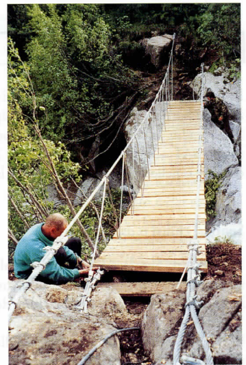
Ultimi ritocchi al ponte Zucal sul Rio Bedù (sentiero O-213) (Foto G. Groaz)
